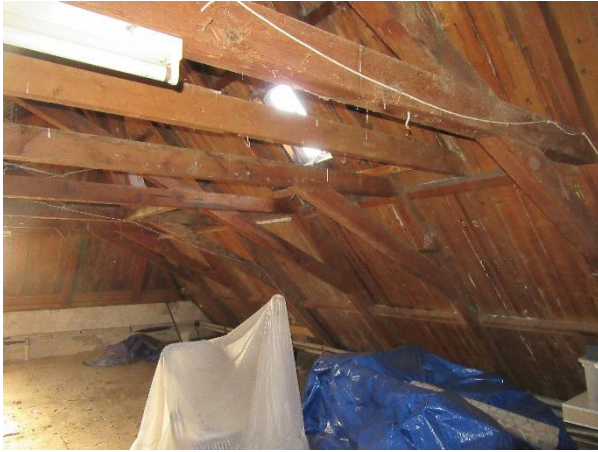
Zolder boven woonhuis
