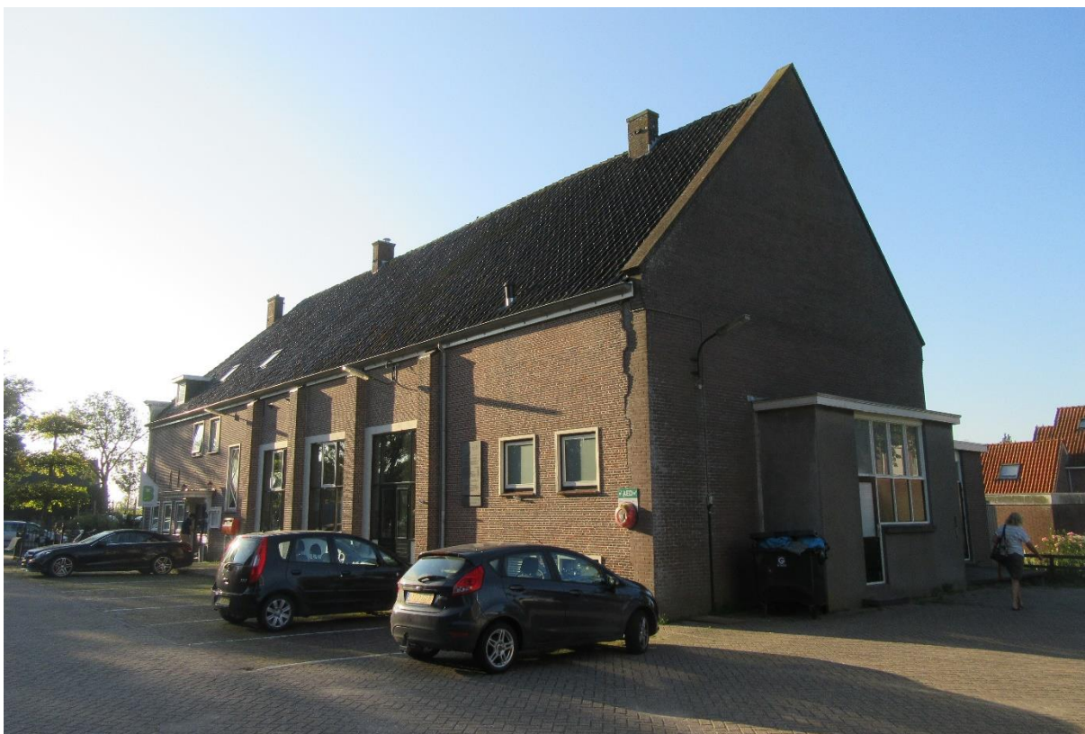
Noord- en westgevels
