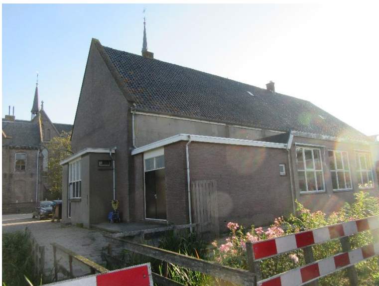
West- en zuidgevels
