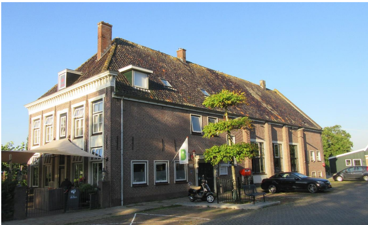
Oost- en noordgevel
